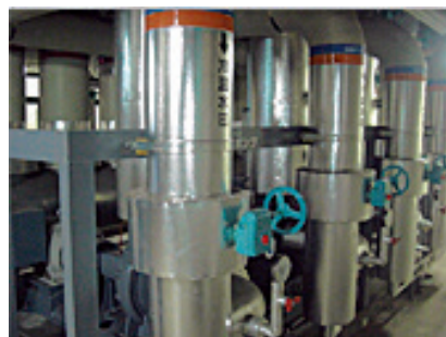
セントラル空調 省エネルギーシステム
